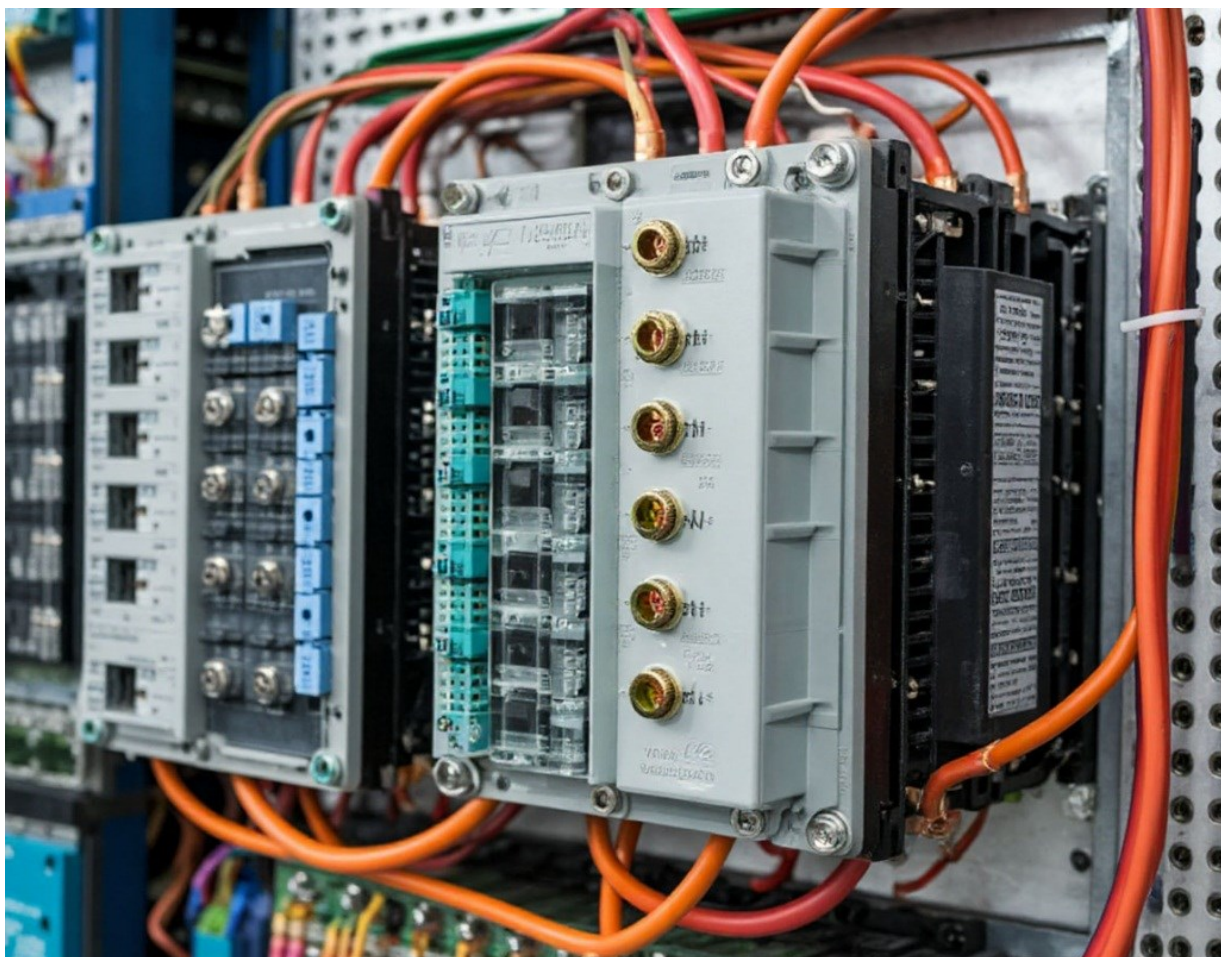
Рисунок 1 – Выключатель постоянного тока большой мощности на основе вакуумных прерывателей и полупроводников
