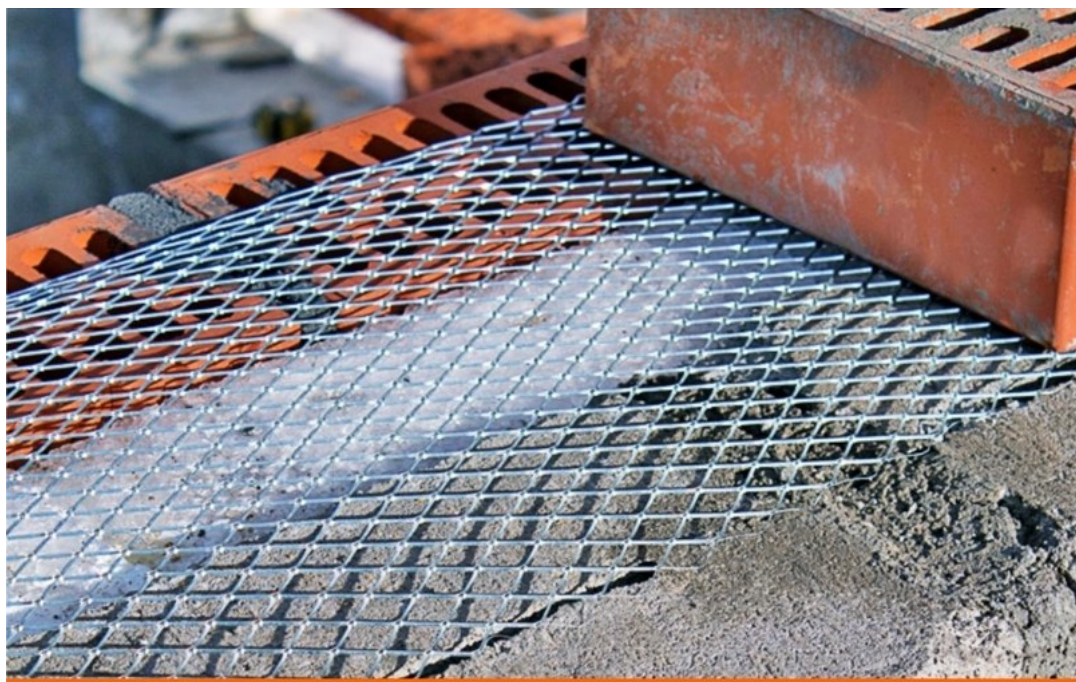
Рисунок 1 – Поперечное армирование кирпичной кладки в виде сетки
